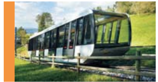
Umbau der Zugerberg Bahn
