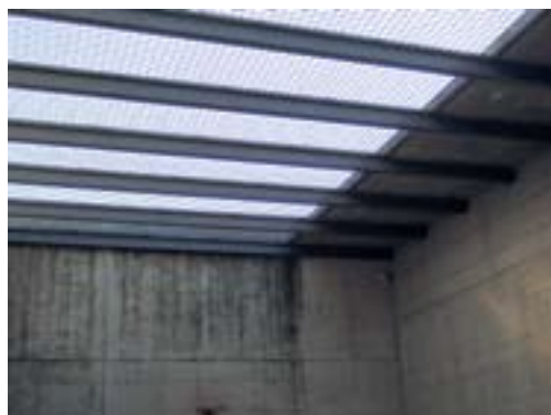
Der Hof ist mit einem Gitter an der Decke gesichert.
