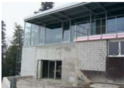
Der neue Anbau bei der Bergstation mit dem verglasten Warteraum.
